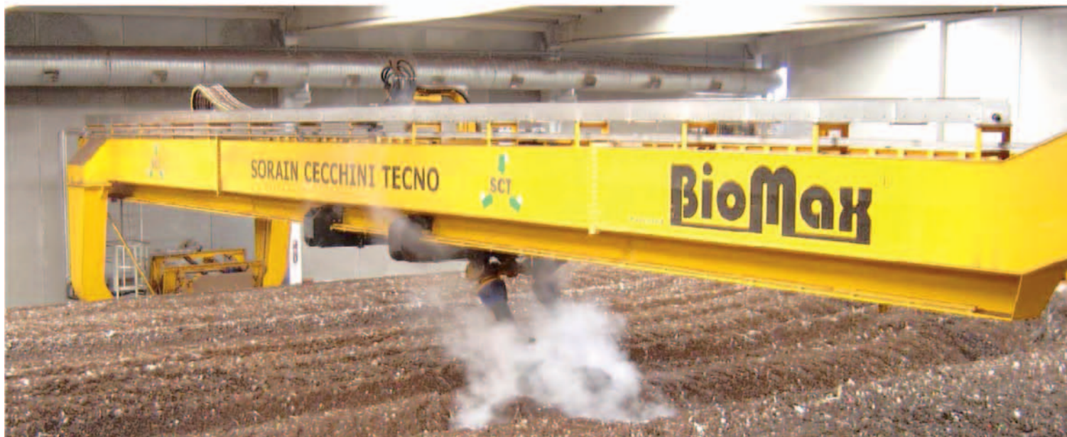
▲ Impianto di compostaggio RSU e fanghi - Murcia - Spagna
